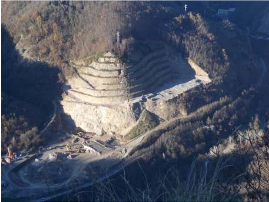
Foto 1: Panoramica della Cava Pratotondo-La Vignola vista da Sassi: Visibili i fronti di escavazione, i piazzali di lavorazione e il piazzale impianti
