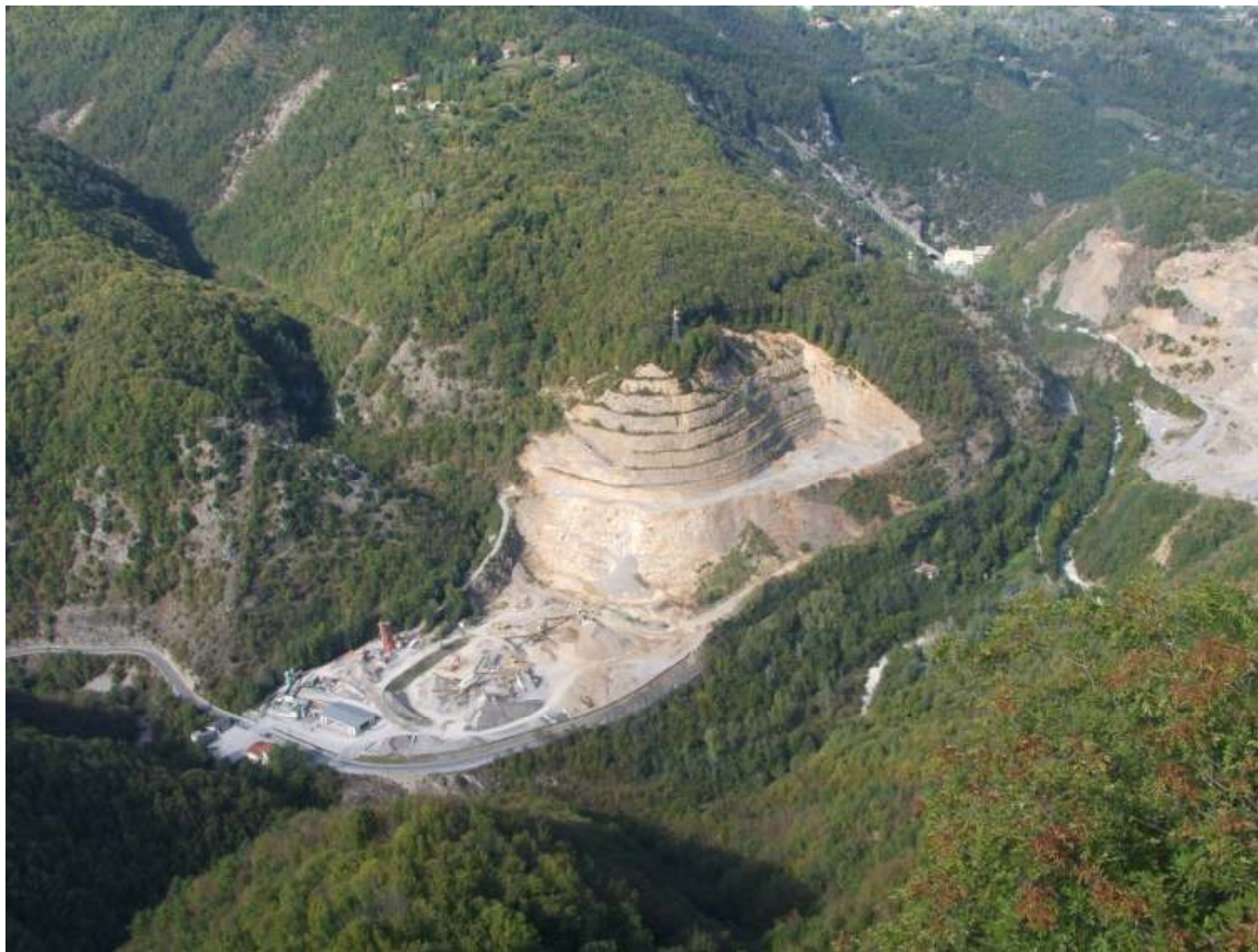
Foto 4: Panoramica della cava Pratotondo –La Vignola visto da Sassi allo stato attuale
