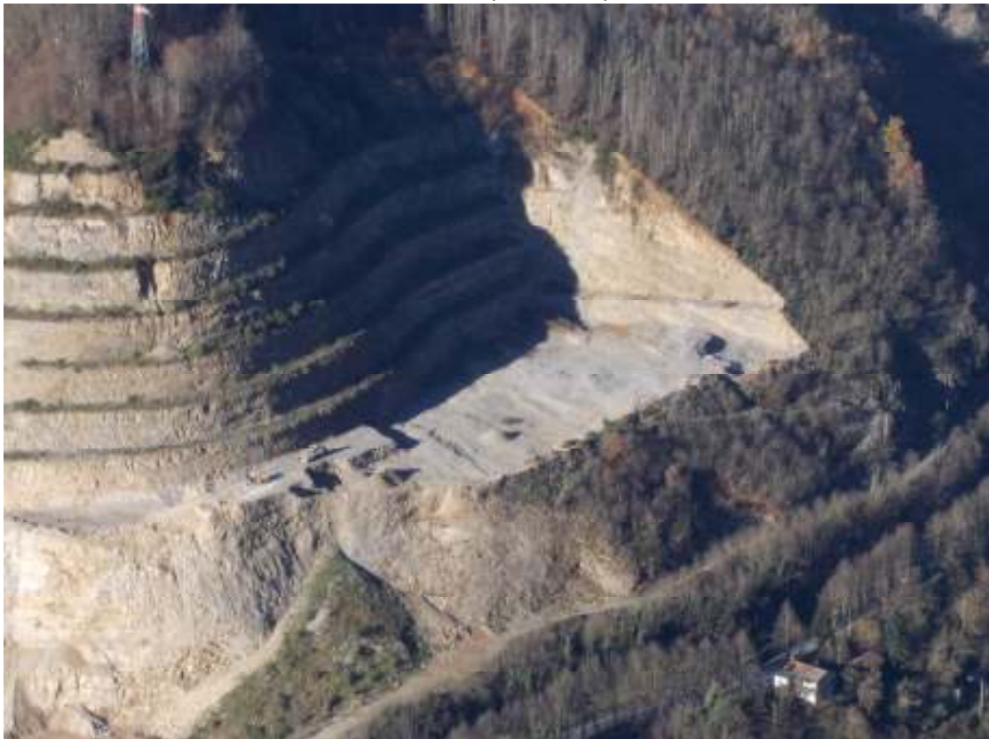
Foto 2 : Particolare della zona Nord della cava con il piazzale a quota 374 m.s.l.m. visto da Sassi
